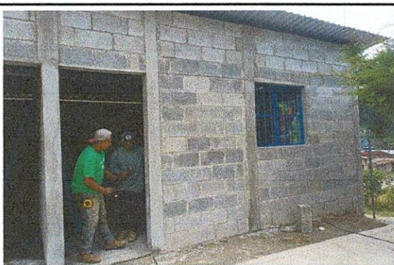
Foto 4: Instalación de ventanas metálicas
