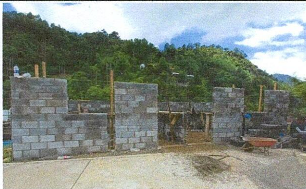
Foto 1: Sustrucción e Instalación de Paredes de Block
