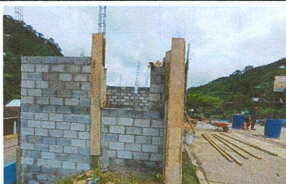
Foto 2: Instalación de columnas 15x20 de concreto
